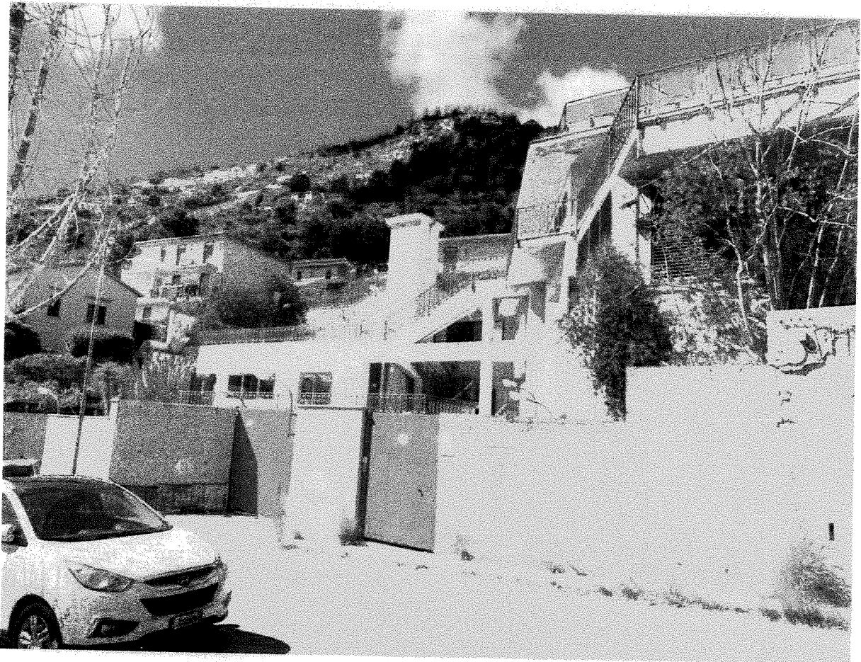
Il piano seminterrato è costituito da uno spazio adibito a garage, un vano ascensore ed un corpo scala che permettono il passaggio ai piani superiori. Di seguito si riporta la planimetria.
